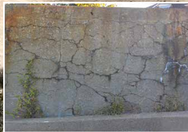
因碱 - 硅酸反应 (ASR) 导致的混凝土破坏。 Concrete failure due to ASR
